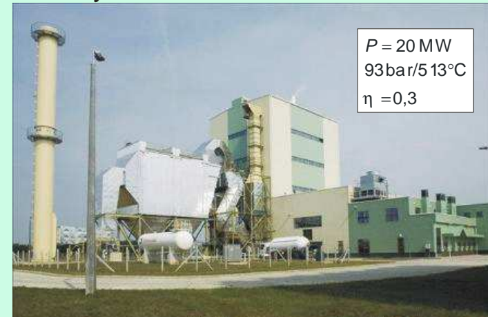
Szakolyi biomassza kondenzációs erőmű
